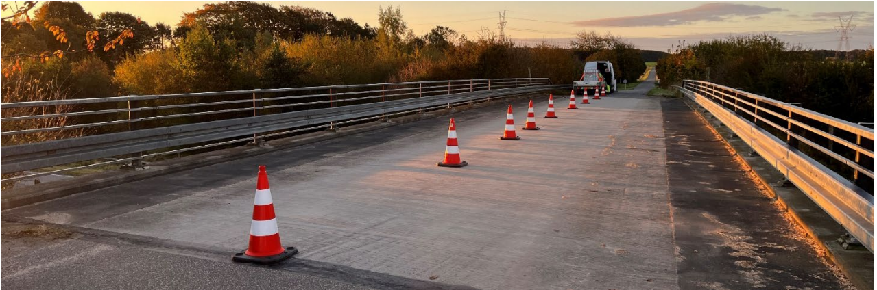
ØF Østermarksvej (2003), med kørebaner direkte på betonen og kunststofbelægning i rabatter.
