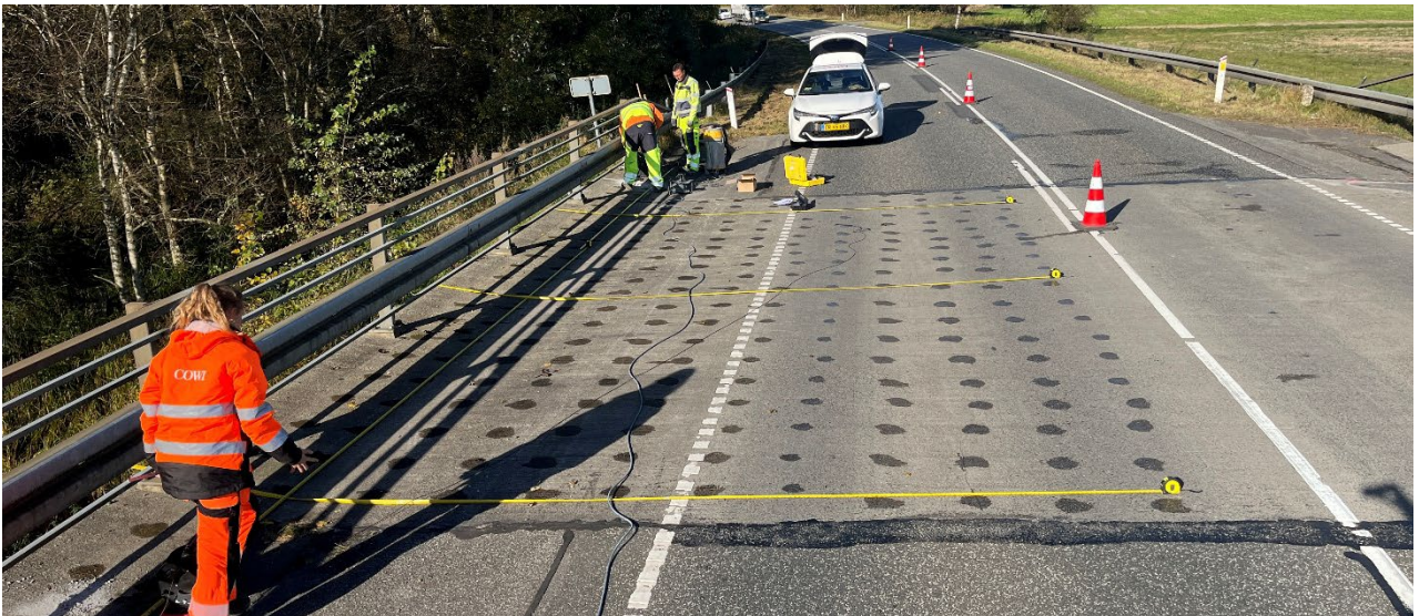
UF Skals Å (1987), hvor hele brodækket er uden fugtisolering og belægninger. Oversidearmeringen undersøges for korrosion med EKP-målinger
